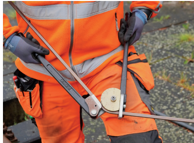
Auf Wunsch sind Heizstäbe verfügbar, die vor Ort mithilfe unseres Spezialwerkzeugs angepasst werden können.
