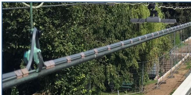
Das Heizkabel wird mit speziellen Klemmen am Fahrdrabt befestigt. Die Klemmen bestehen aus Phosphorbronze, um galvanische Korrosion zu vermeiden. Das Heizkabel hat eine dreieckige Form. Dadurch lässt es sich sehr einfach auf dem Fahrdrabt befestigen und die Form sorgt für guten thermischen Kontakt mit dem Fahrdrabt.
